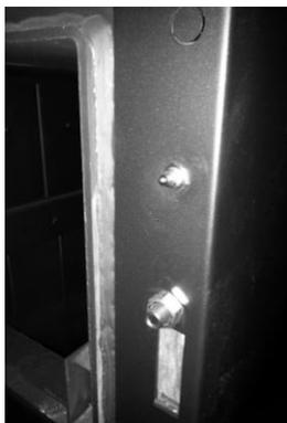
Figura 2 – Microswitch colocado na parte frontal da caldeira
