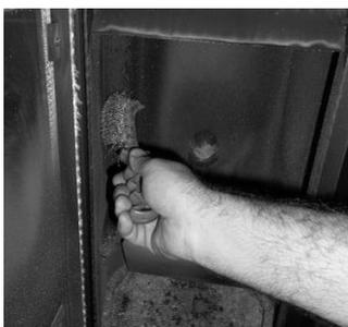
Figura 26 - Limpeza do interior da compacta a água
