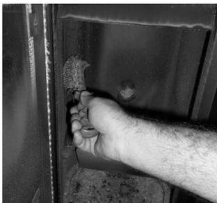
**Figura 29 - Limpeza do interior da compacta a água**
